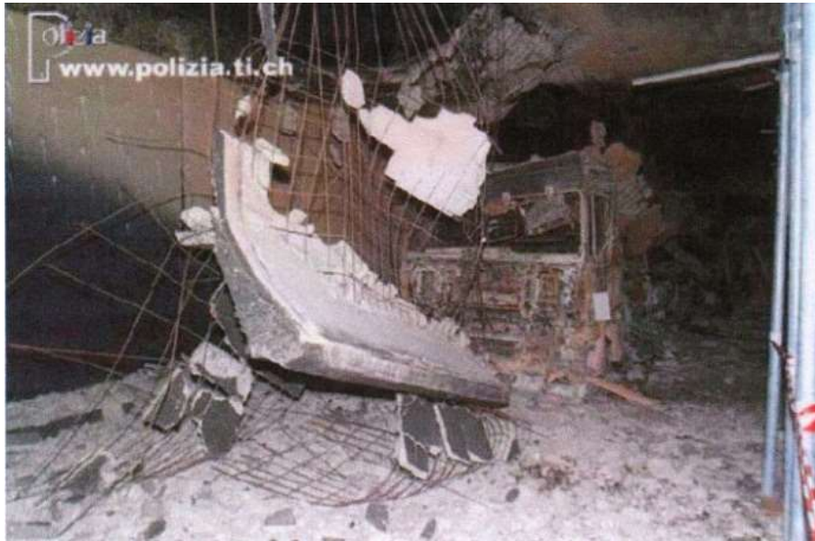
3. ábra: Gotthárd-alagút betonfelületének réteges leválása [5]
