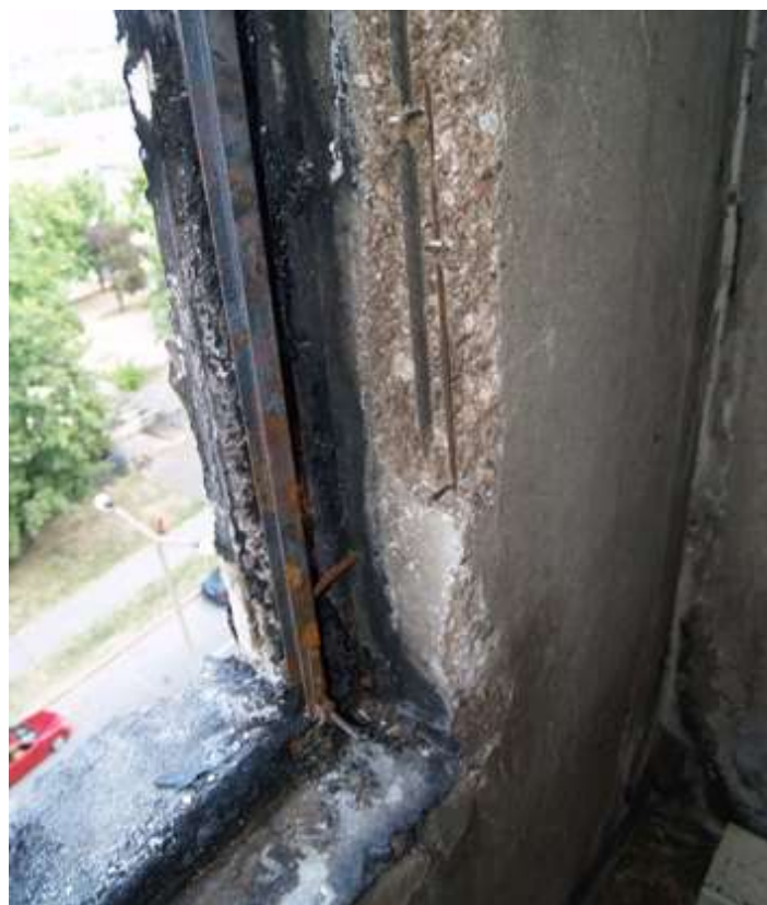
7. ábra: Betonfedés sajátos leválása az ablak mentén, sarokban, a Miskolc, középster u. 20 sz. alatti paneles lakóépület 2009. augusztus 15-i tüzeseténél [14]
