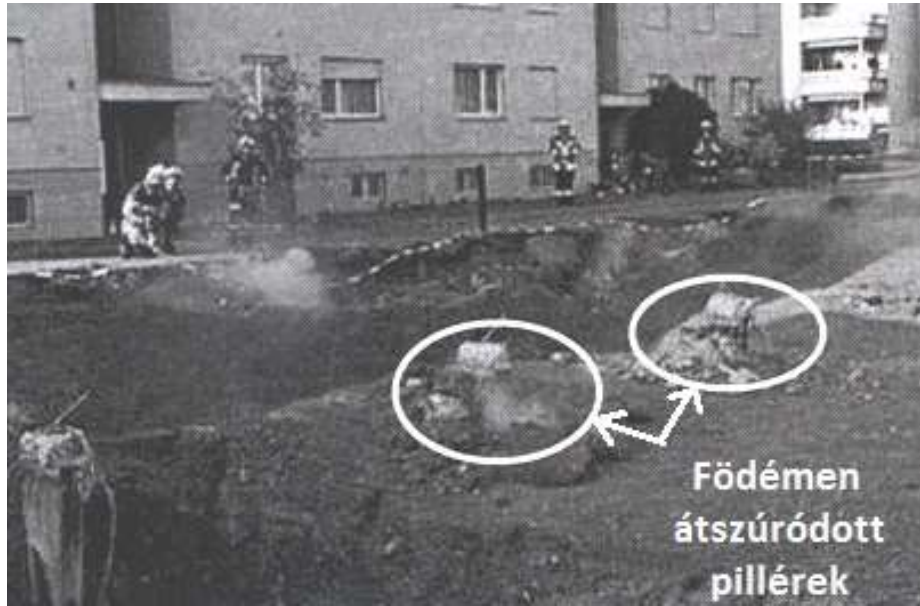
1. ábra: Gretzenbach-i mélygarázs tönkremenetele, 2004 [2]
