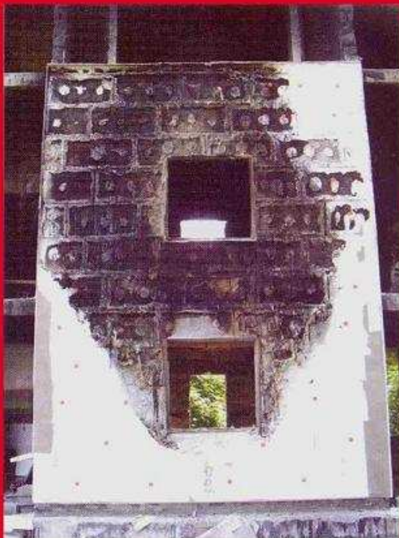
A felület károsodása III.
